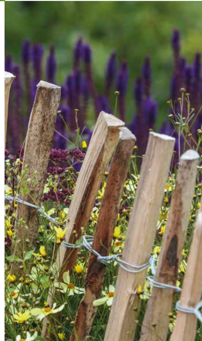
De kastanjestaken zijn stevig vastgebonden met gegalvaniseerd vlechtdraad.
