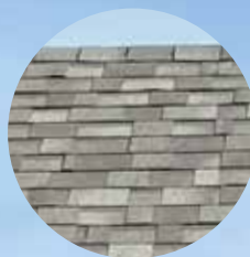
Dakbedekking in Cambridge grijze shingles
