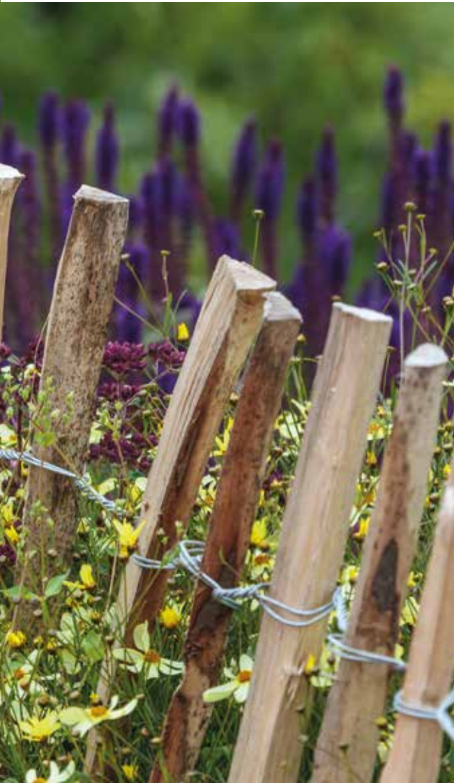
De kastanjestaken zijn stevig vastgebonden met gegalvaniseerd vlechtdraad.
